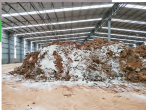
项目现场施工图
